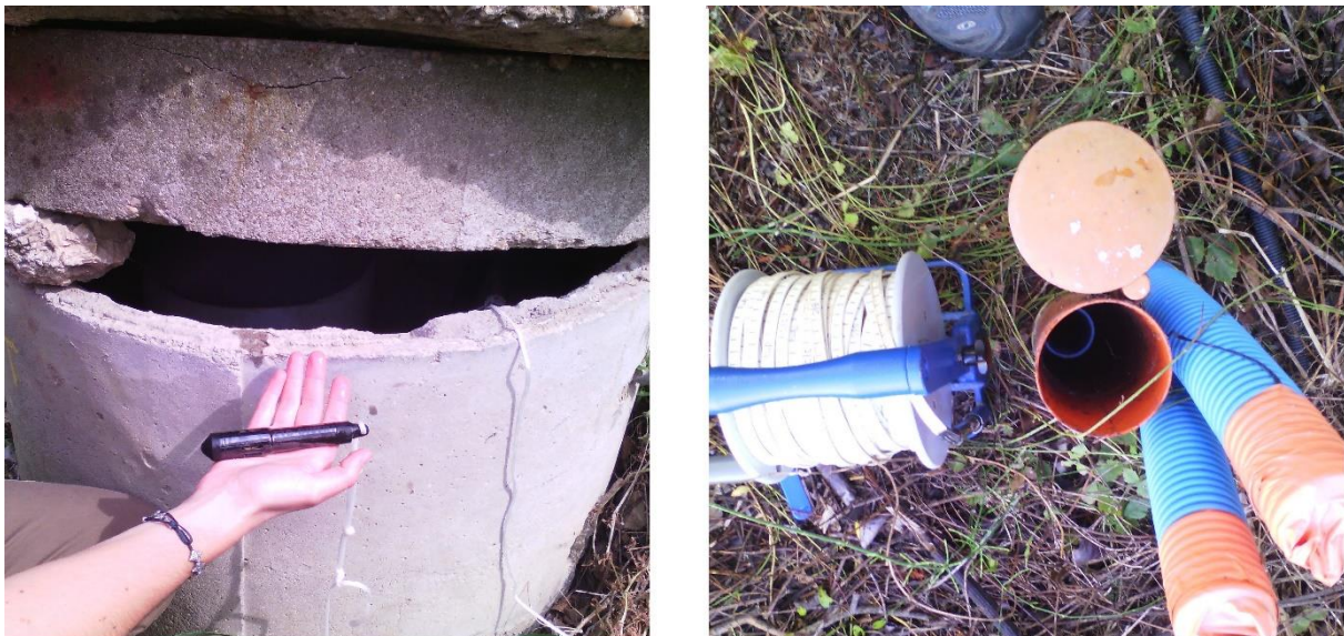
Figure 9 : A gauche : sonde DIVER et puits SNCF1. A droite : sonde piézométrique et piézomètre PZ1
